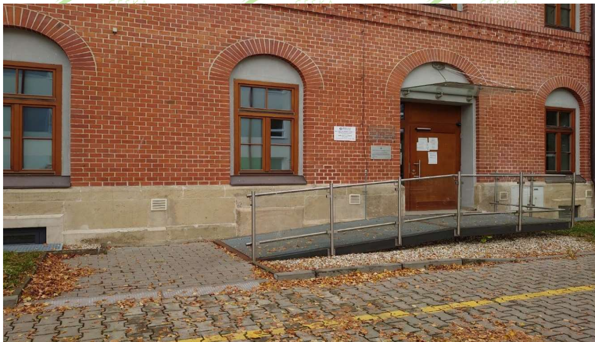
vstup do budovy
