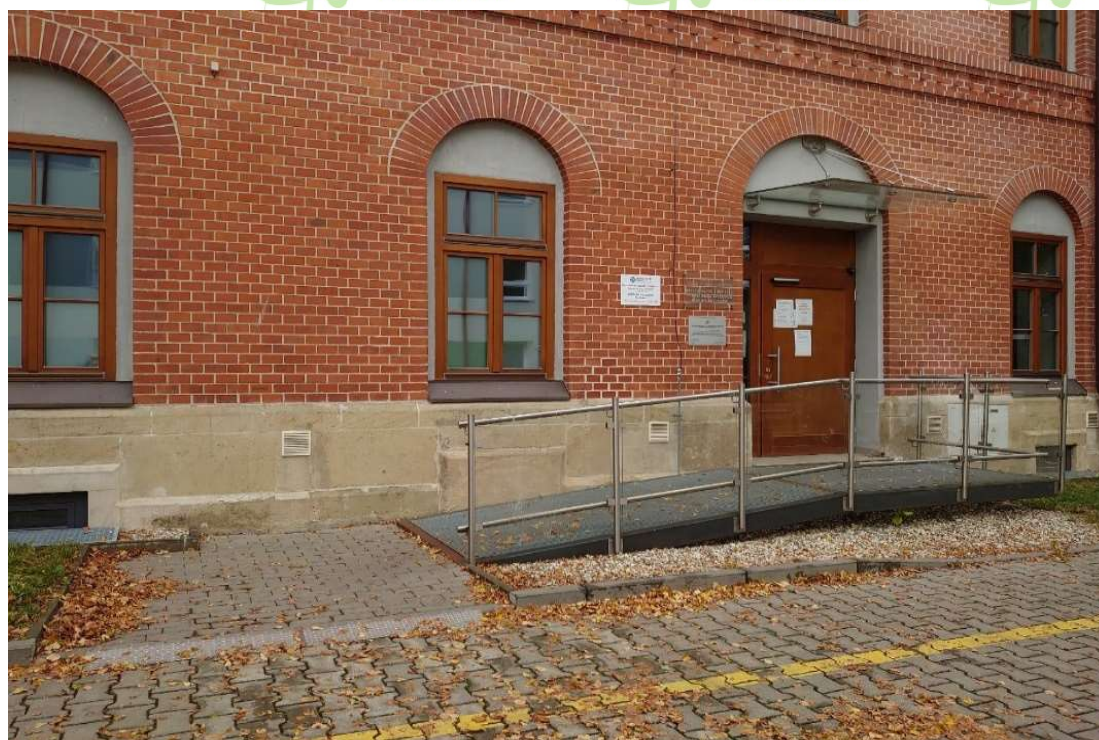
vstup do budovy
