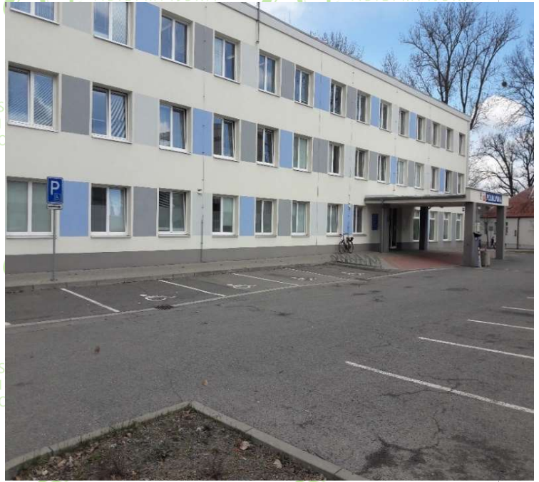
hlavní vstup do budovy polikliniky
