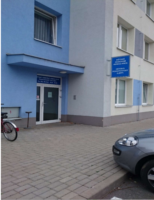
vedlejší vstup do budovy polikliniky
