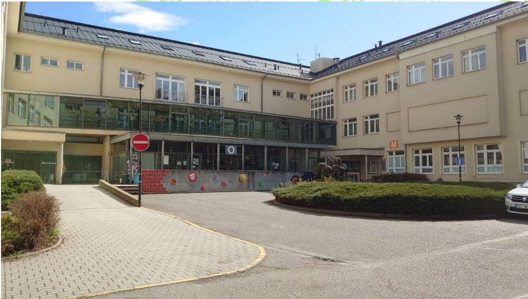
Monoblok - budova M (přístup vlevo)
