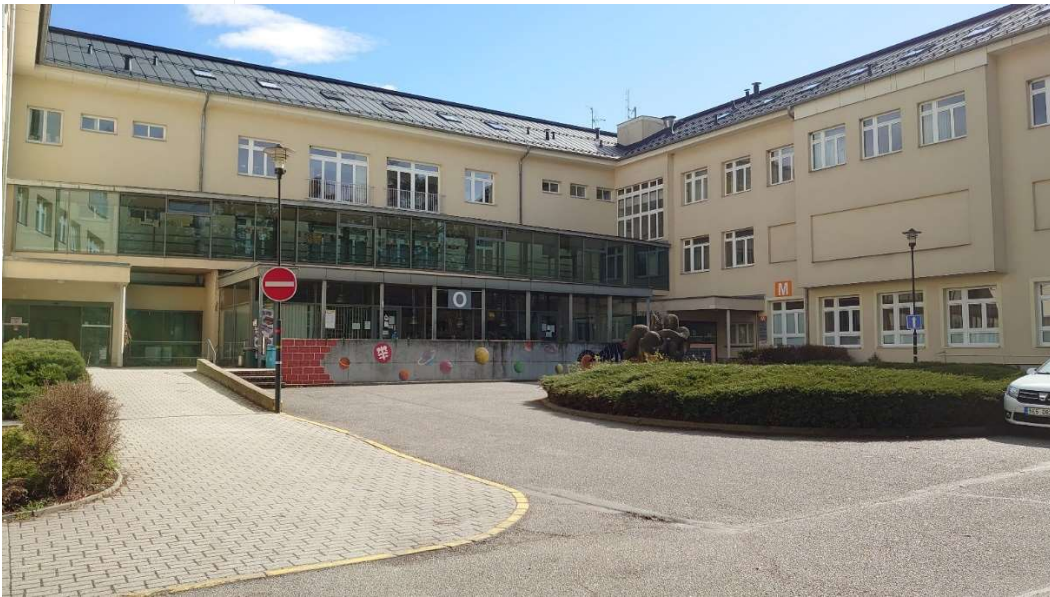
Monoblok - budova M (přístup vlevo)
