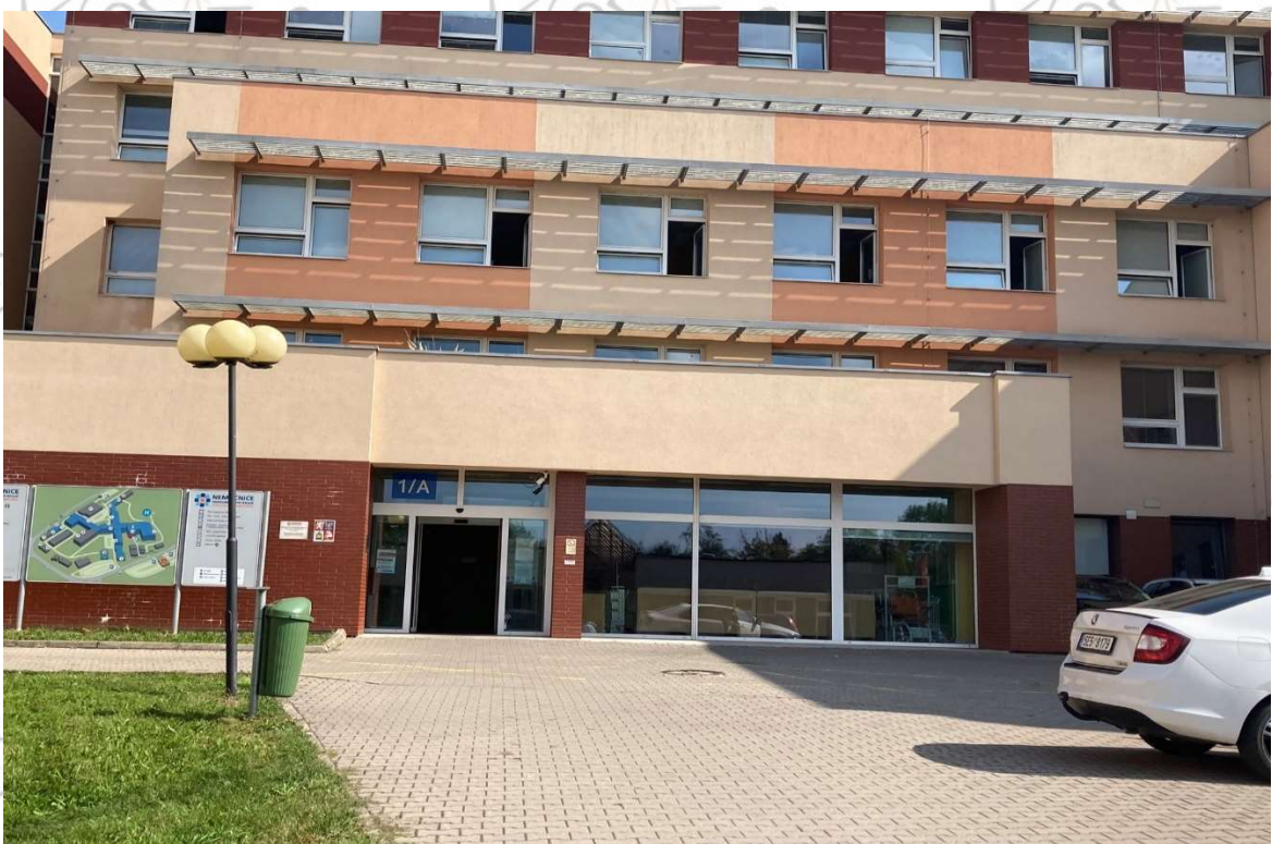
Hlavní vstup 1/A (od zadního vjezdu do areálu nemocnice)
