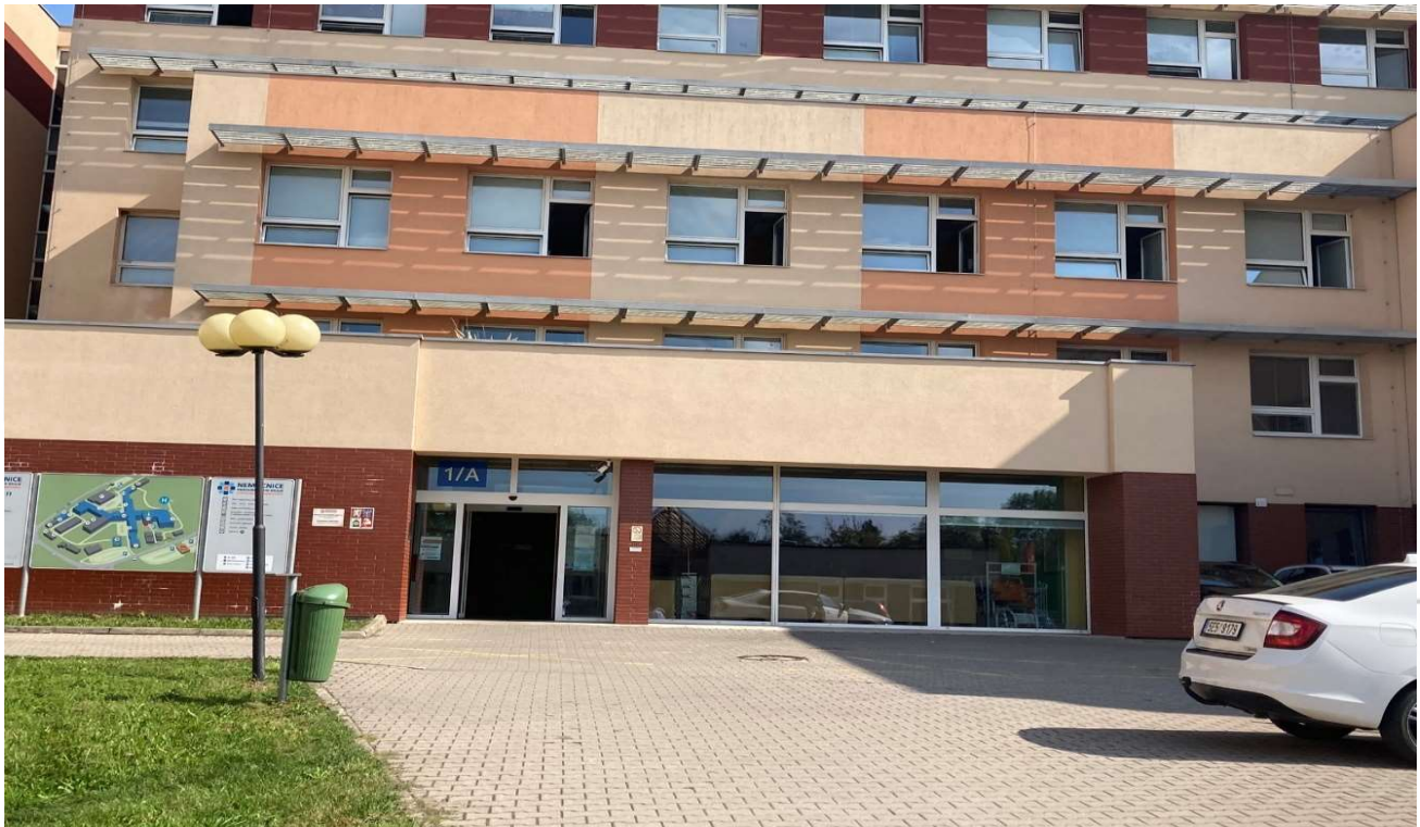
Hlavní vstup 1/A (od hlavního vjezdu do areálu nemocnice)
