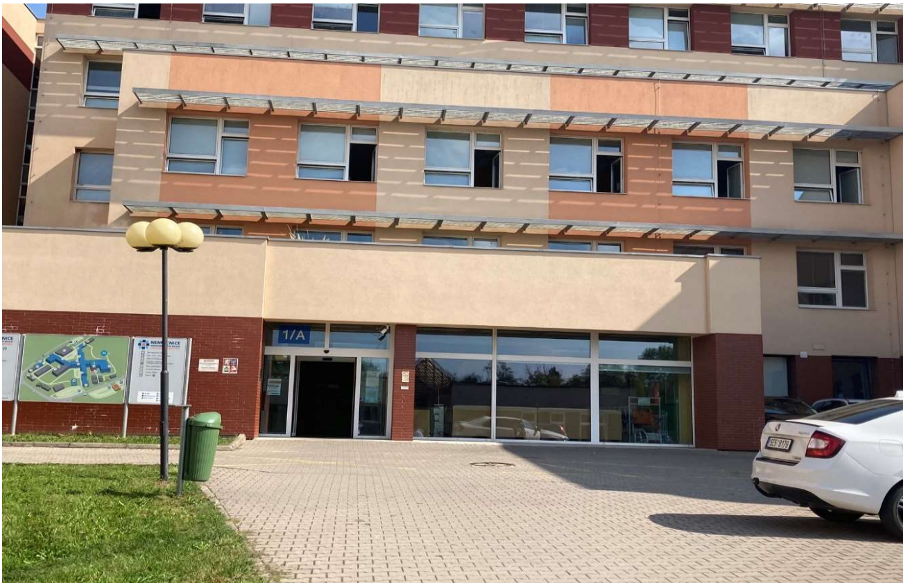
Hlavní vstup 1/A (od hlavního vjezdu do areálu nemocnice)
