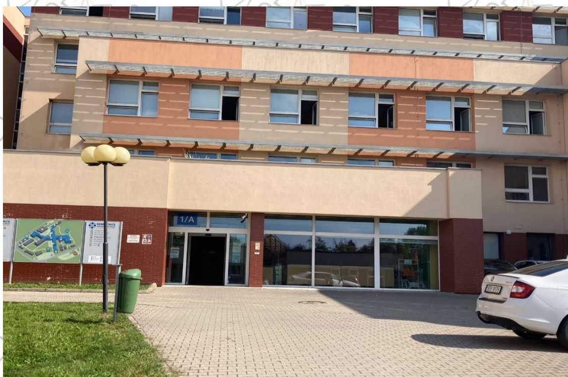
Hlavní vstup 1/A (od hlavního vjezdu do areálu nemocnice)
