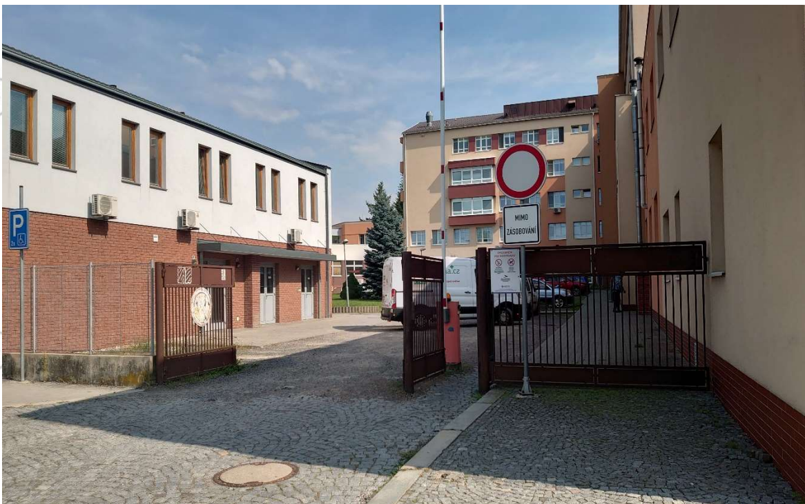
Přístup ke vstupu 1/B (od Lékárny)
